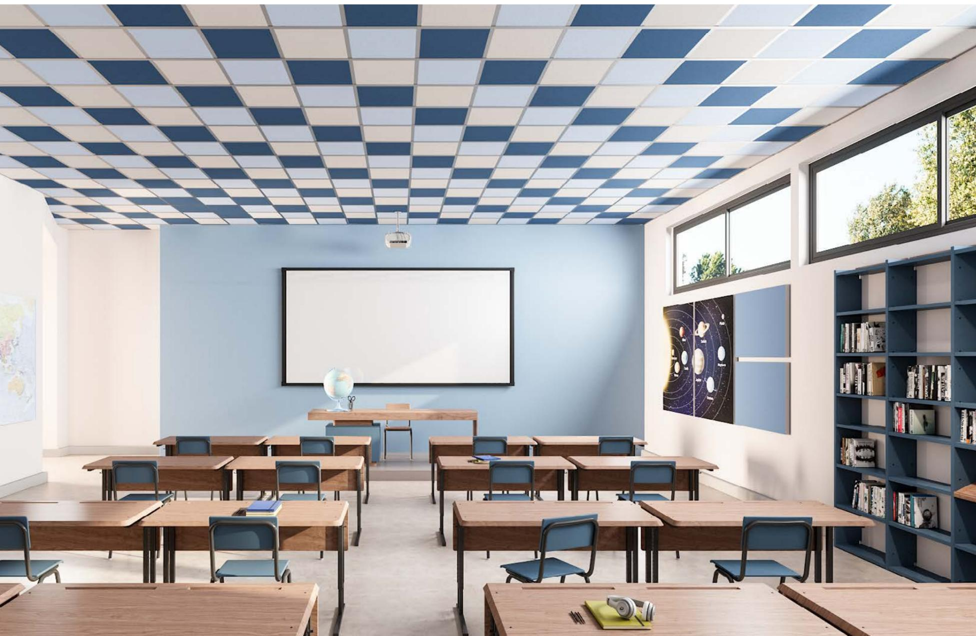
Uffici e ambienti pubblici in generale spesso presentano una struttura con controsoffittatura modulare con orditura metallica. Pensando a queste strutture è nato **isospace Sky**, un "quadrotto fonoassorbente" in formato 60x60 cm e in spessore 2 cm ideale per sostituirsi naturalmente al quadrotto in cartongesso.
